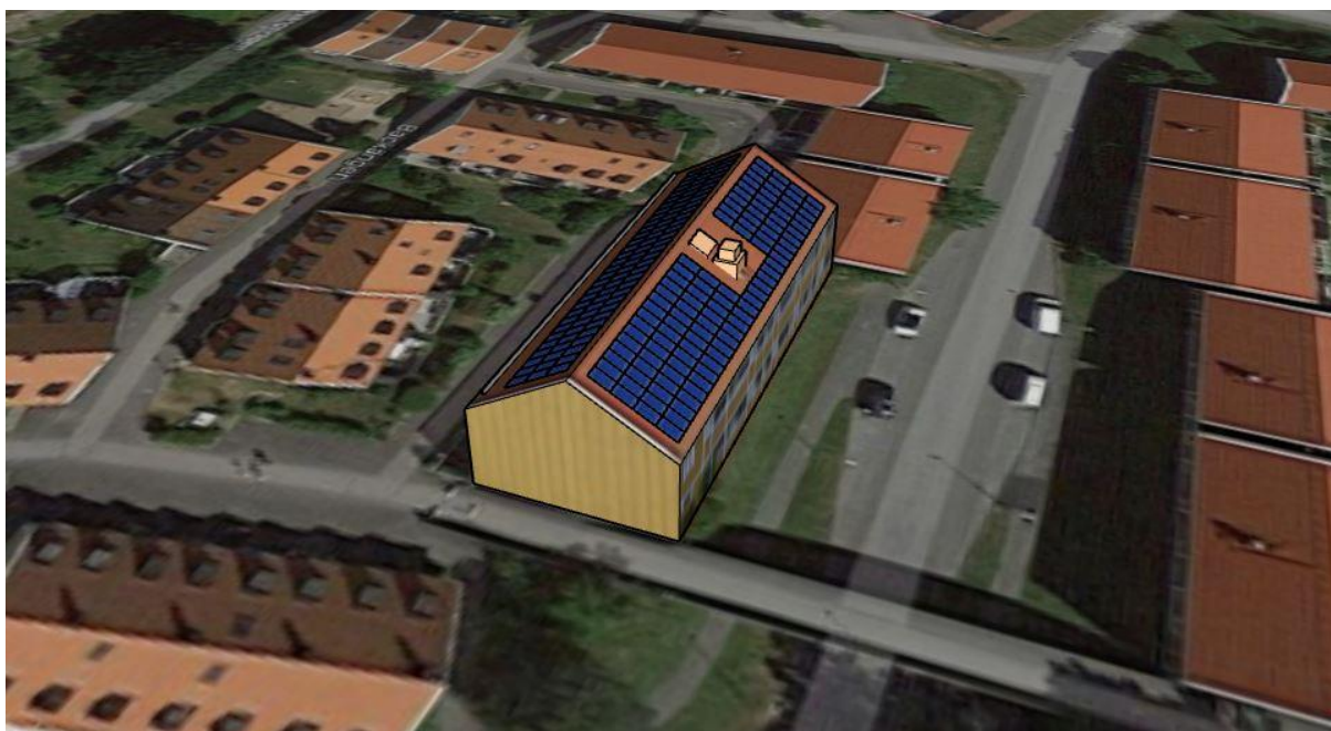
Figur 5: Illustration av möjligt "pilothus" med 54 kW solceller på Backängen 27 enligt Systemförslag 2.
